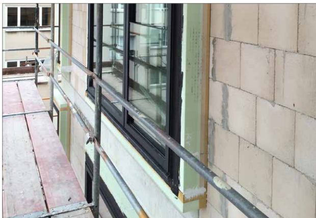
Fensteranschluss mit thermischer Isolation, mechanische Befestigung möglich
